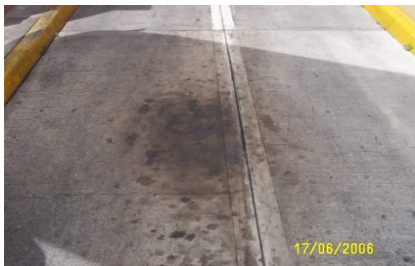
Фигура 1. Оцветената бетонна настилка преди приложение на MICROCAT-SMPL®
